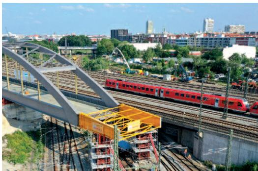
Das erste große Bauwerk der 2. Stammstrecke steht: Die riesige Stabbogenbrücke westlich der S-Bahn-Station Hirschgarten wurde auf ihre endgültige Position über den Münchner Südring geschoben. 95 Meter Länge, 16 Meter Höhe und 1.350 Tonnen Gewicht – das sind die Eckdaten des Stahlkolosses. Er besteht aus rund 80 Fertigteilen, die DB montierte ihn in zehn Monaten vor Ort. Über die neue Brücke fahren später die S-Bahnen zum Tunnelportal kurz vor der Donnersbergerbrücke.
